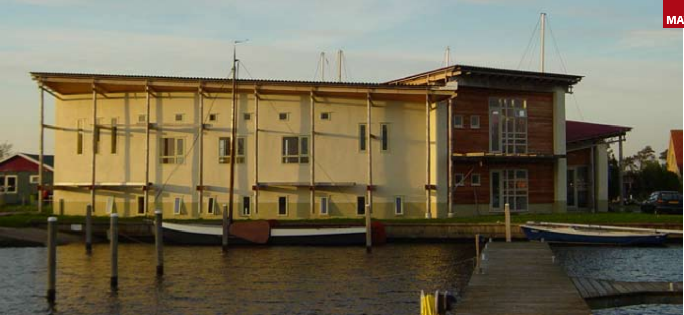
Zes meter hoge lemen muur op het zuidwesten aan het water
